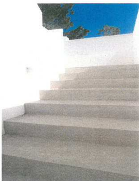
↑外階段施工例
